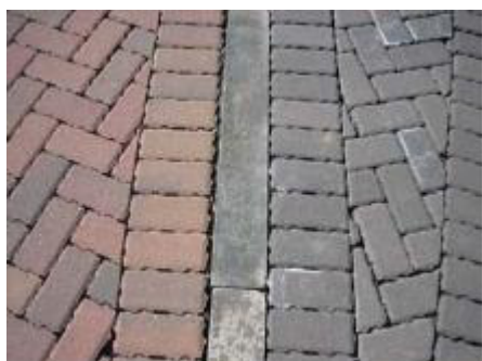
Figura 41.- Ejemplo de pavimento permeable
